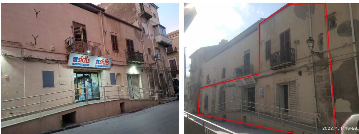
Figura 3 – Prospetto Sud – Accesso all'immobile
