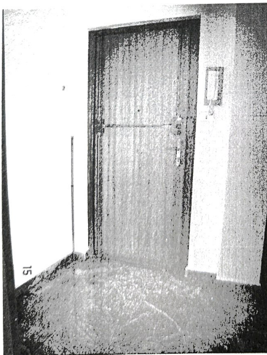
INGRESSO UNITA' ABITATIVA
